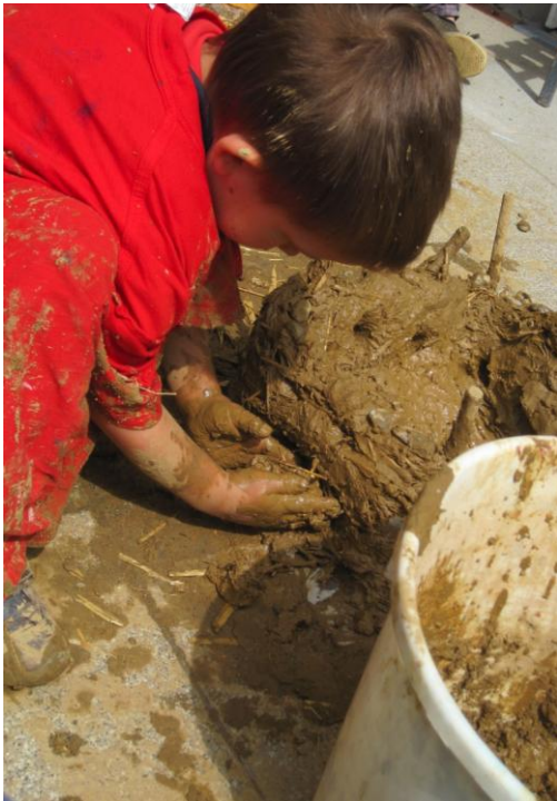
Hausbau mit Lehm, Stroh und Weidenzweigen
